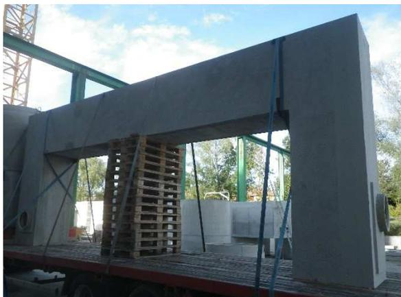
Canal de mesure avec regard amont et aval
